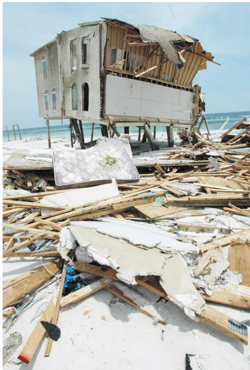
Maison endommagée par l'ouragan Dennis le 18 juillet 2005 en Ontario, au Canada.
