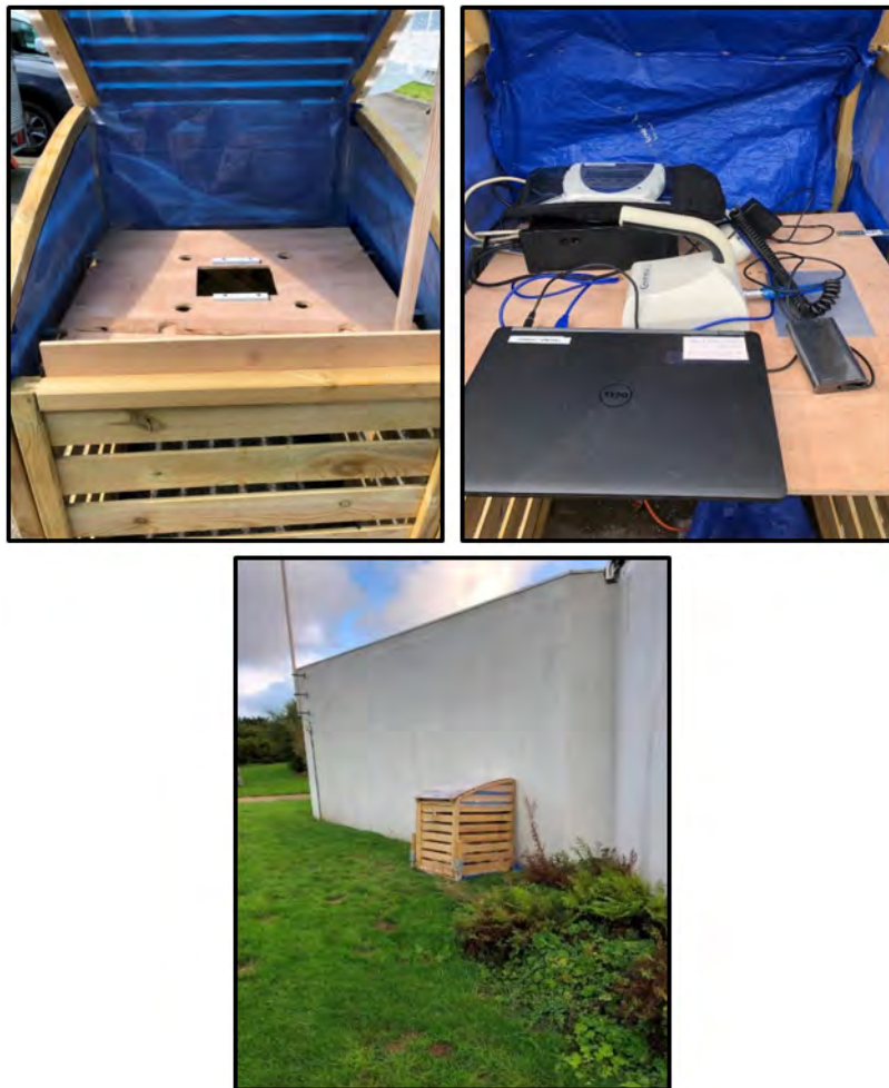
FIGURE 2.9 – Station de mesures continues de la concentration atmosphérique du ^{85}\text{Kr} sur le site de Ludiver, dans le cadre de la campagne DISKRYNOC. L’abri de protection des dispositifs est composé de deux parties : une partie supérieure fermée, permettant de protéger l’ordinateur et la batterie, et une partie inférieure aérée vers laquelle est orientée la fenêtre de comptage.
